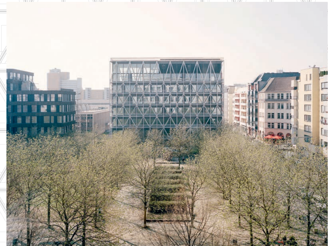
taz Neubau, Sicht vom Besselpark, Foto: © Rory Gardiner
